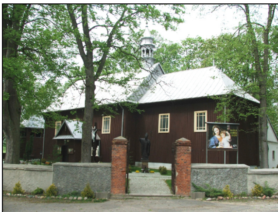
Fot.1. Kościół parafialny p. w. MB Różańcowej w Łaznowie, ob. wpisany do rejestru zabytków
