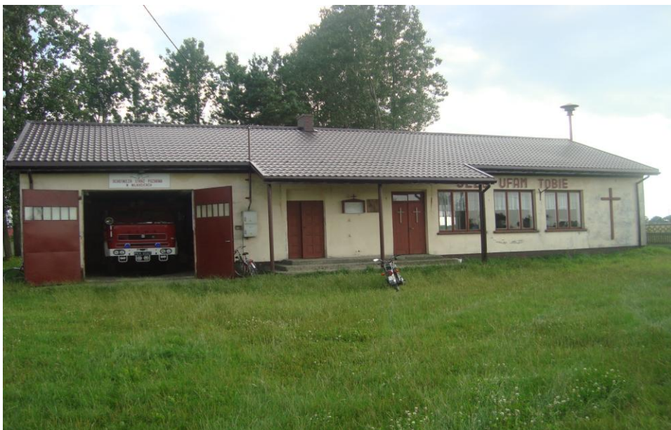
Budynek świetlicy z garażem OSP i kaplicą
